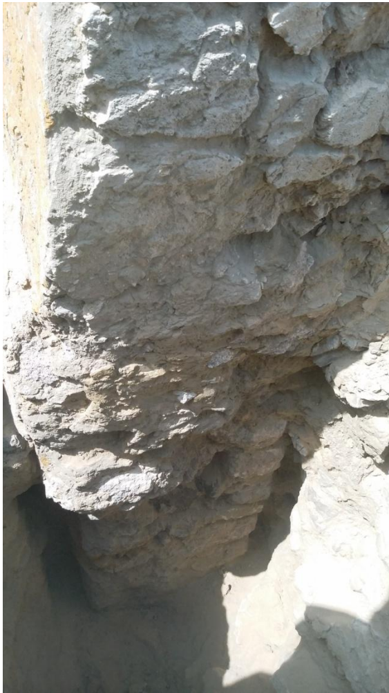
Photo n°3 : Coupe transversale du mur du mausolée Sidi Mahmoud en première vue à gauche et les rajouts à l'intérieur et à l'extérieur sont identifiables à partir des couleurs et annotations à droite.
